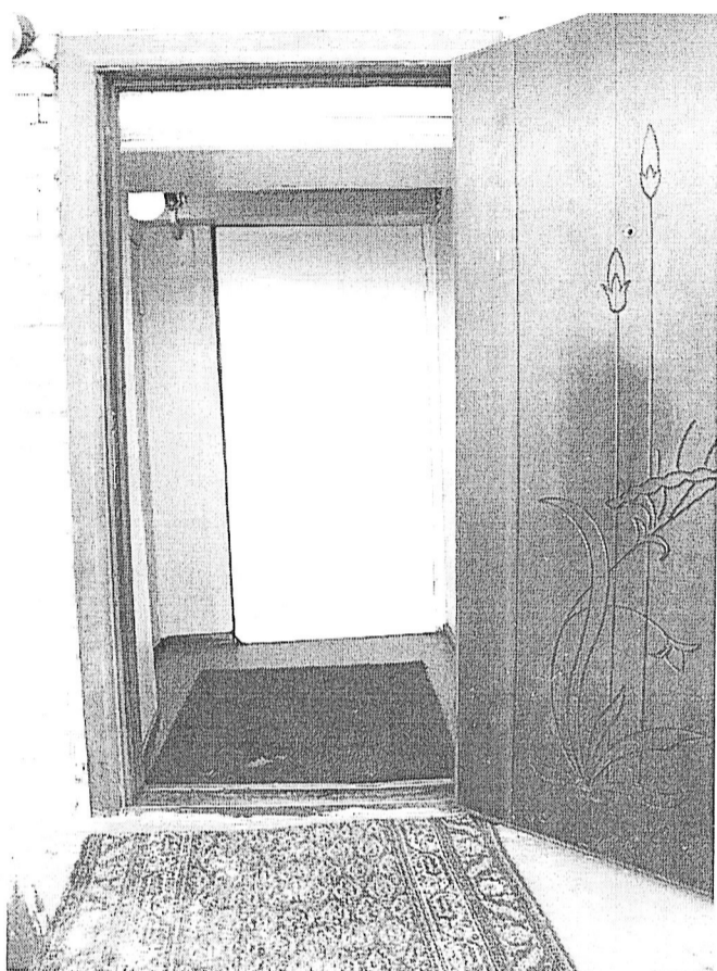
Фото № 23 Тамбур входа 1
