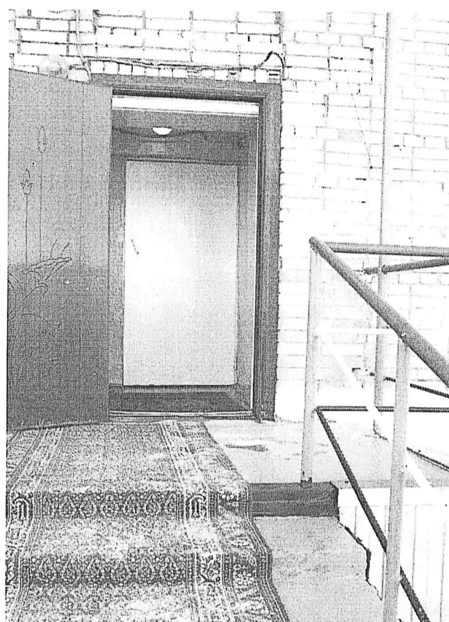
Фото № 24 Тамбур входа 2
