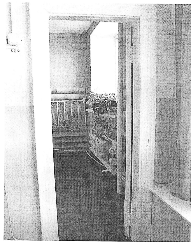
Фото № 45 Дверь в умывальную комнату
